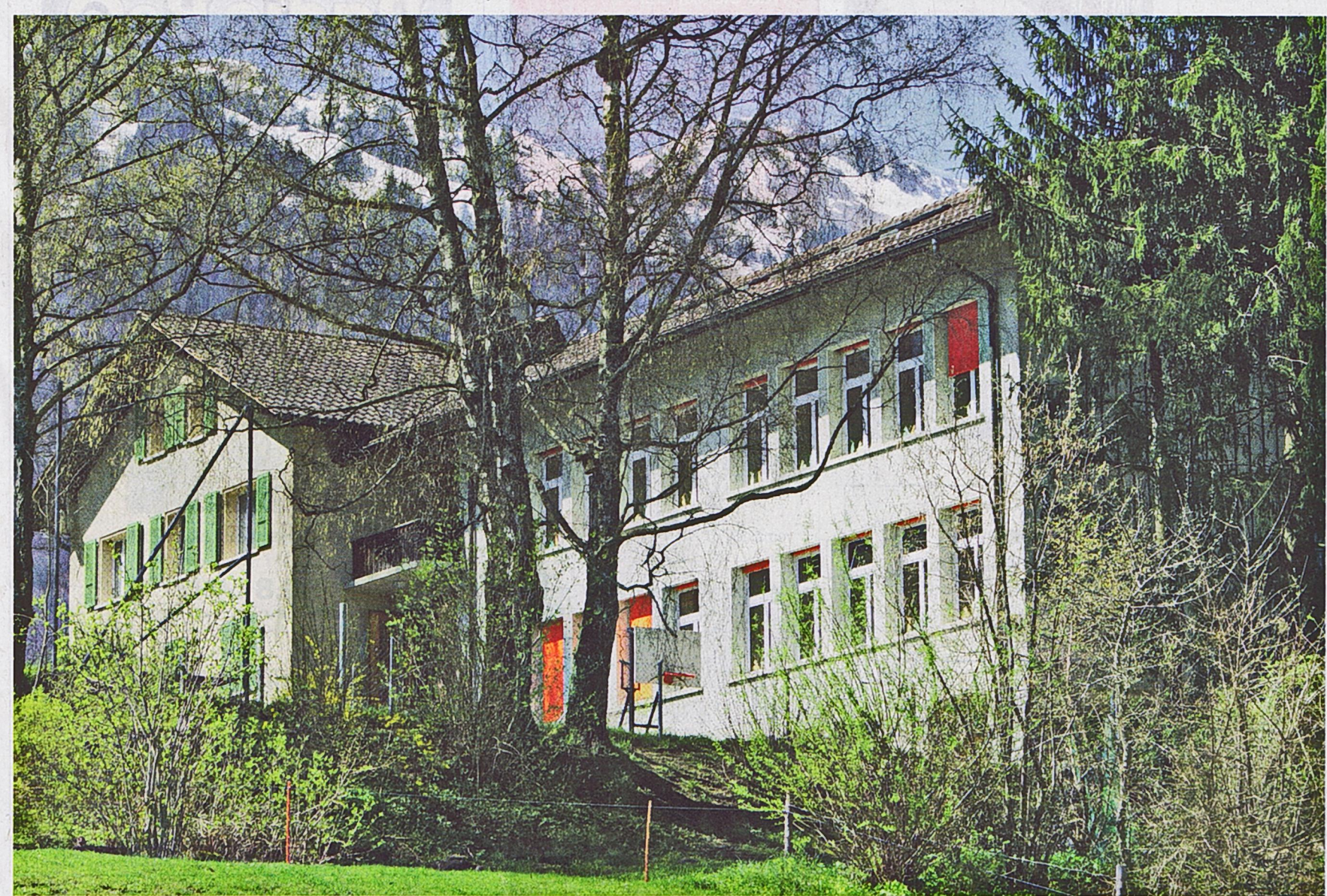
Im Schulhaus Höfen sollen ab August 2015 drei Klassen der Primarstufe der neuen Gemeinde Stocken-Höfen unterrichtet werden.
